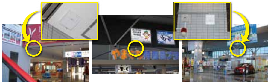
空港内の主要施設で無線LANの利用が可能
